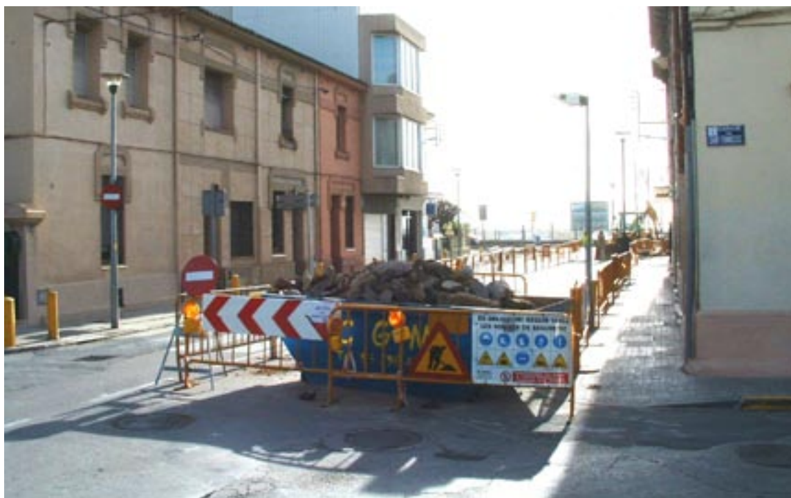
Obres a la carretera de Vilassar de Dalt, a tocar amb la carretera nacional
