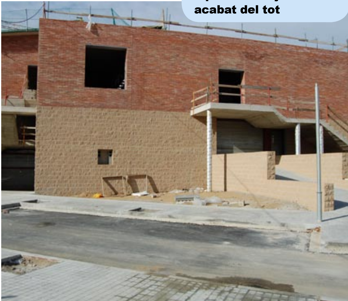
L'aparcament soterrani comptarà amb 122 places
