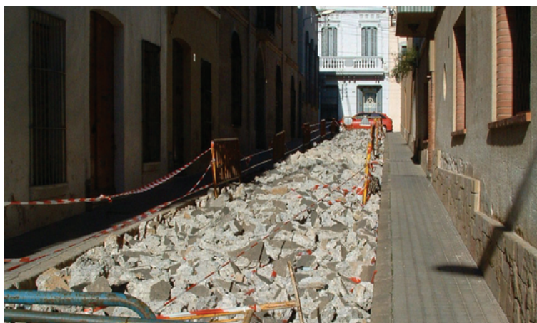
Obres de remodelació al carrer del Segle
