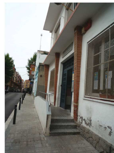
e 5.20 Edifici Santa Tecla
