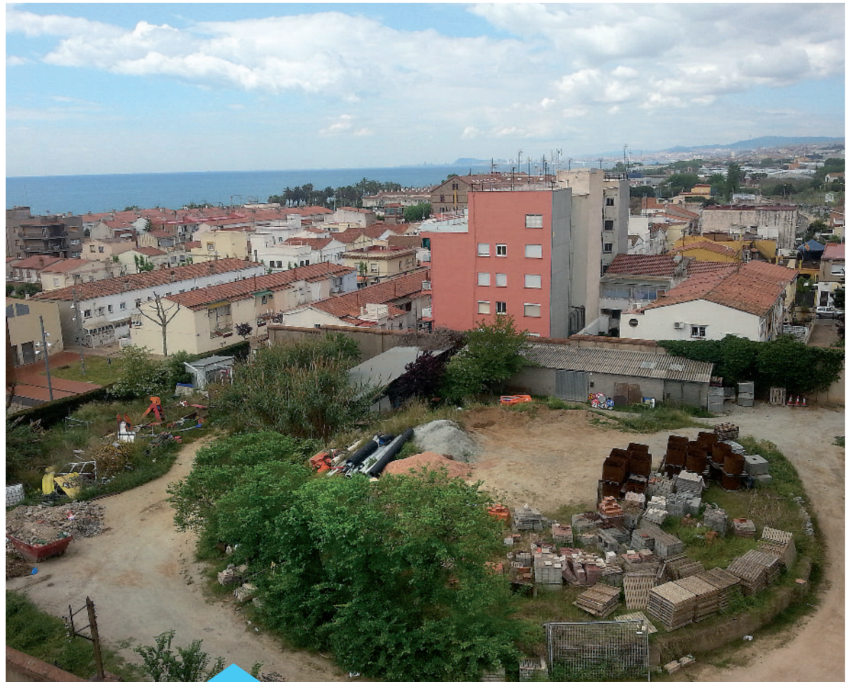
Espai on es construirà la nova plaça Salvador Moragas i Botey
