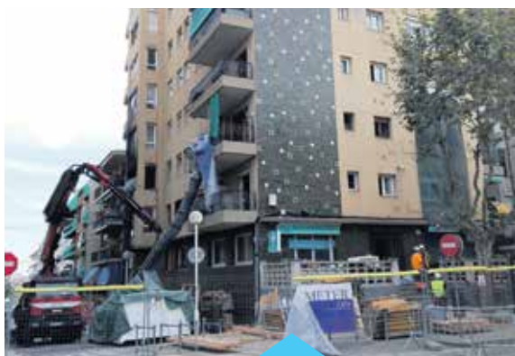
Treballs d'apuntament a l'edifici sinistrat de la Gran Via
