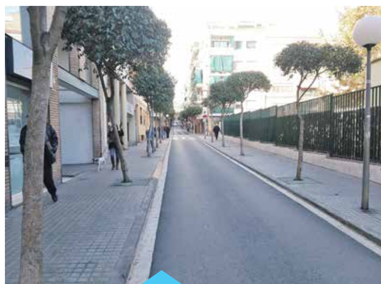
Tram del carrer Dr.Fleming asfaltat
