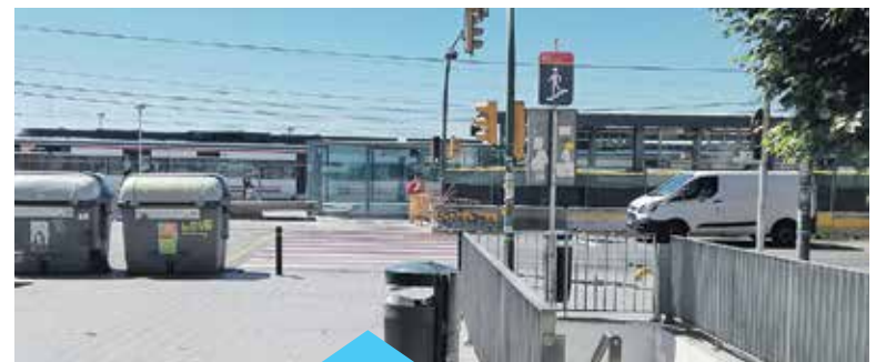
El pas soterrat es recuperarà i s'ampliarà la vorera
